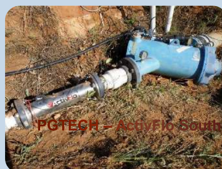
Lắp đặt cho hệ thống tưới cây trong nông nghiệp
