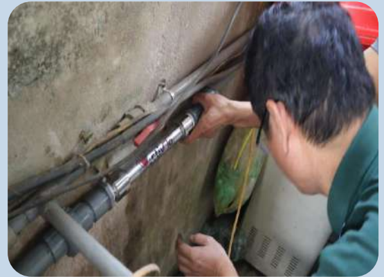
Lắp đặt cho tháp giải nhiệt và hệ thống làm mát cho công ty sản xuất bao bì tại Hà Nội
