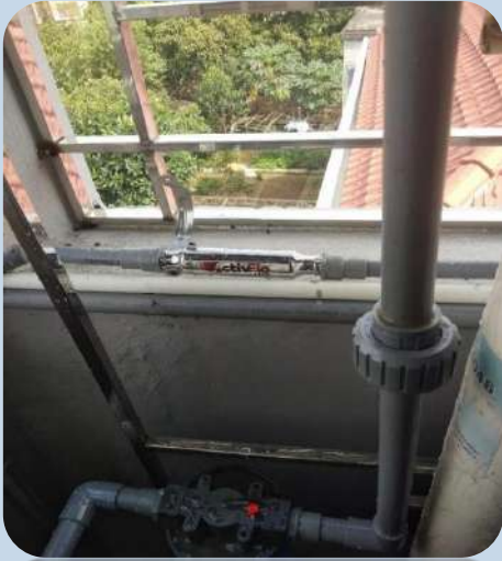
Lắp đặt tại Yên Bái
