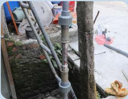
Lắp đặt cho nước sinh hoạt tại Bắc Giang
