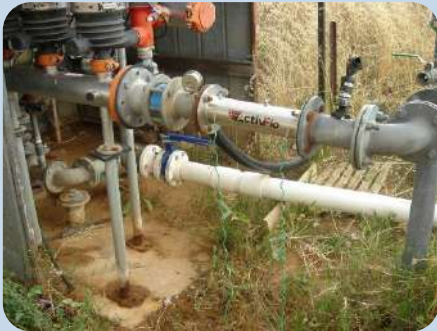
Lắp đặt cho hệ thống cấp nước
