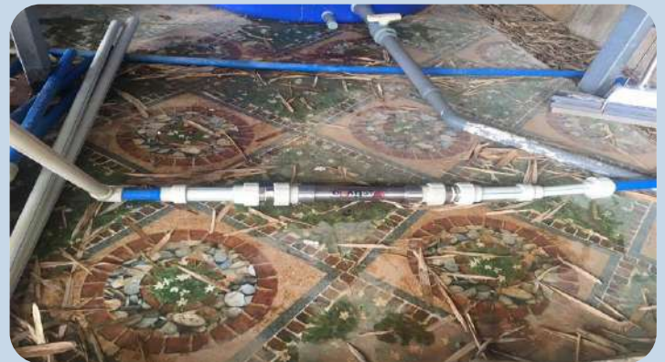
Lắp đặt tại Vũng Tàu
