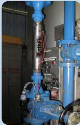
Lắp đặt cho nồi hơi
