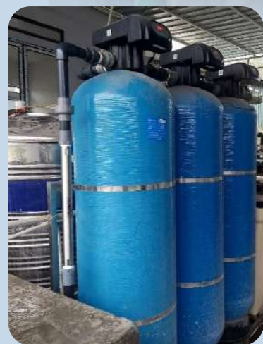
Lắp đặt cho hệ thống lọc RO tại nhà máy sản xuất hóa chất Xây dựng ở Hòa Bình
