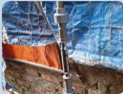
Lắp đặt cho trang trại tại Bắc Giang
