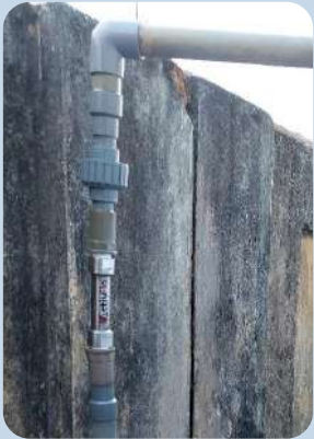
Lắp đặt tại Bắc Ninh
