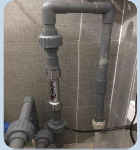
Lắp đặt tại Hưng Yên
