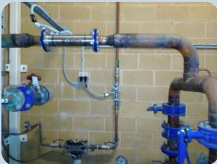
Lắp đặt cho hệ thống cấp nước nổi hơi
