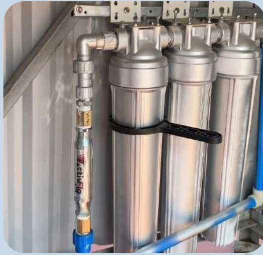
Lắp đặt tại TP Sơn La – Tỉnh Sơn La
