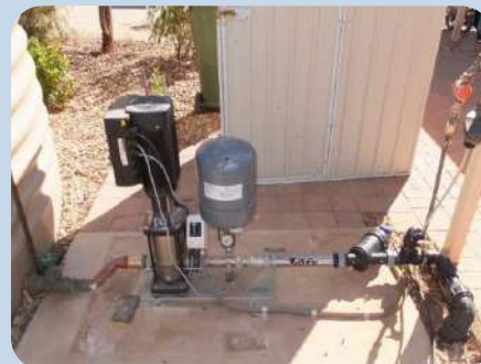
Lắp đặt cho giếng khoan
