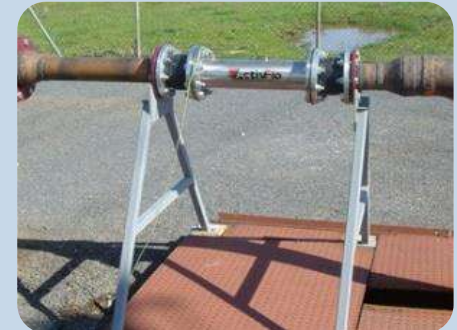
Lắp đặt cho hệ thống cấp nước nhà xưởng
