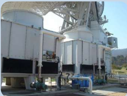
Lắp đặt cho hệ thống Chiller, tháp giải nhiệt của nhà máy
