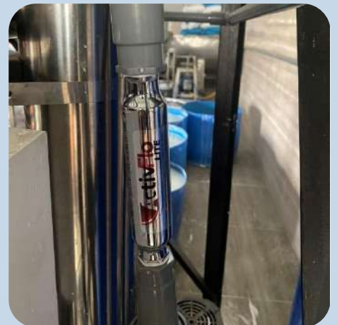
Lắp đặt tại Cần Thơ
