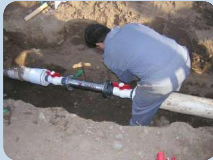
Lắp đặt cho hệ thống cấp nước
