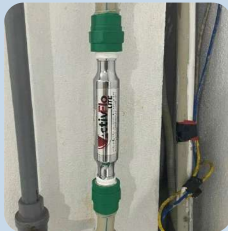
Lắp đặt tại Cần Thơ
